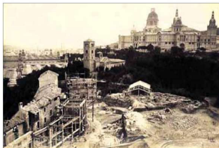
1928-1929. El Poble Espanyol quan estava en construcció
